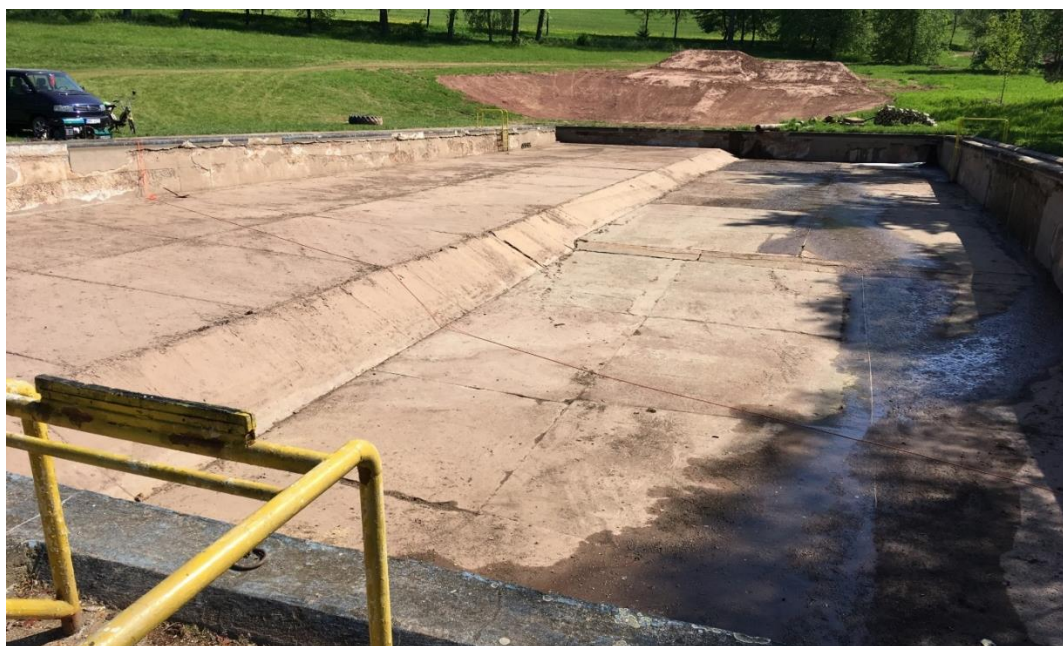
Obrázek 7 Bazén přírodního koupaliště před zahájením úprav areálu
